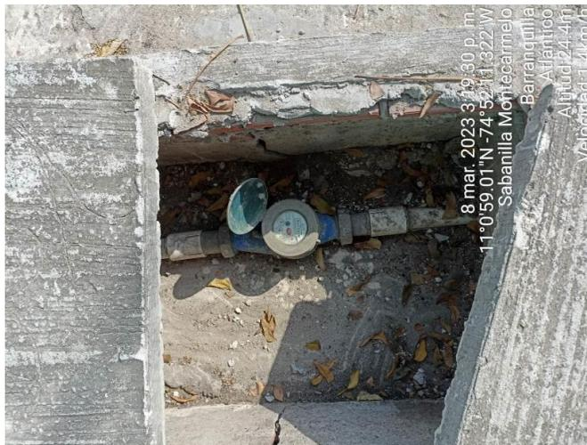
**Fotografía Medidor de caudal debidamente instalado y funcionando.**
